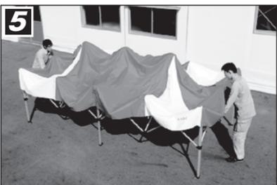
トラスバー下側のV字部分を持ち上げながら、さらに外側へ引っ張り、本体フレームを最大まで広げます。
