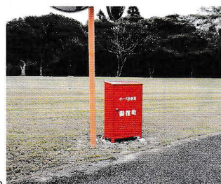
消火用ホース
